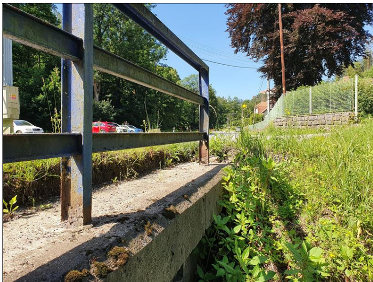
Koroze zábradlí
